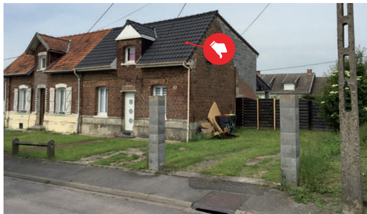
Utilisation de tuiles noires vernissées tranchant avec le reste de la cité.
