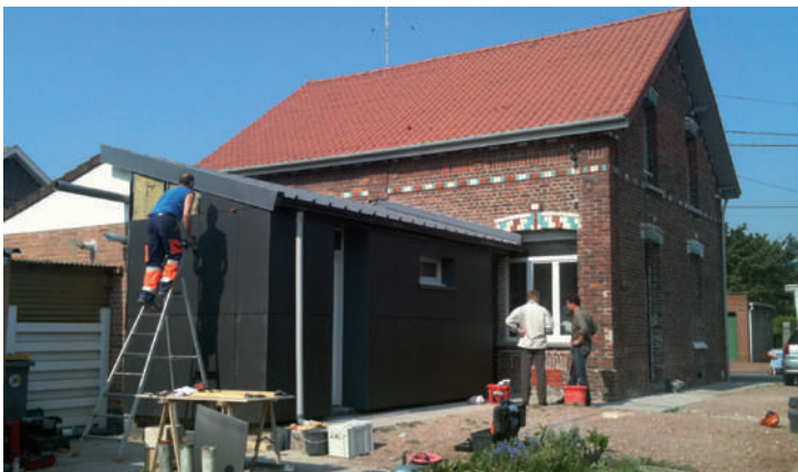
Isolation extérieure d'une extension.
