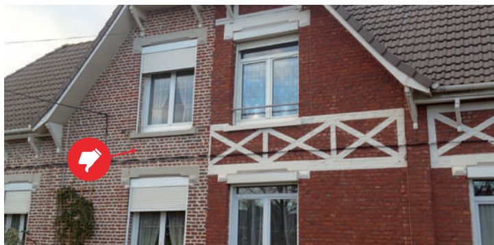
Sablage et joints blancs (à gauche), privilégiez un nettoyage des briques sous faible pression, avec des joints rouges tirés au fer et une remise en valeur des décors (à droite).
